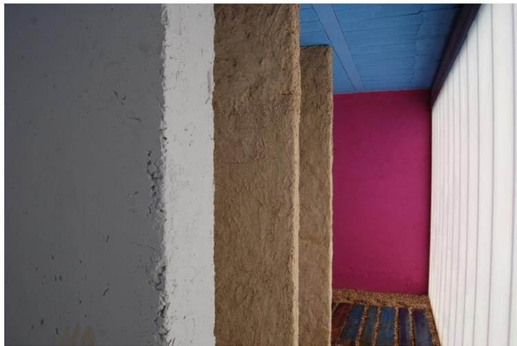
Ligado a este espacio y en los campamentos del 2014 se realizó una construcción utilizando materiales de reciclaje como pales junto con los materiales tradicionales utilizados en Tierra de Campos como son el barro y el adobe.
